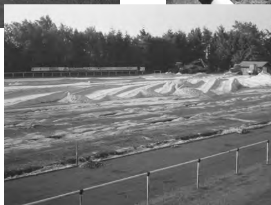
Abschieben der Grasnarbe und Auftragen der Rasentragschicht
